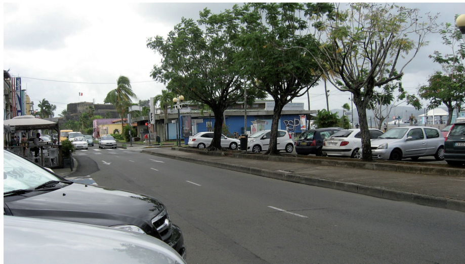
Ⓞ Rue Ernest Desproges 2014 avant travaux
